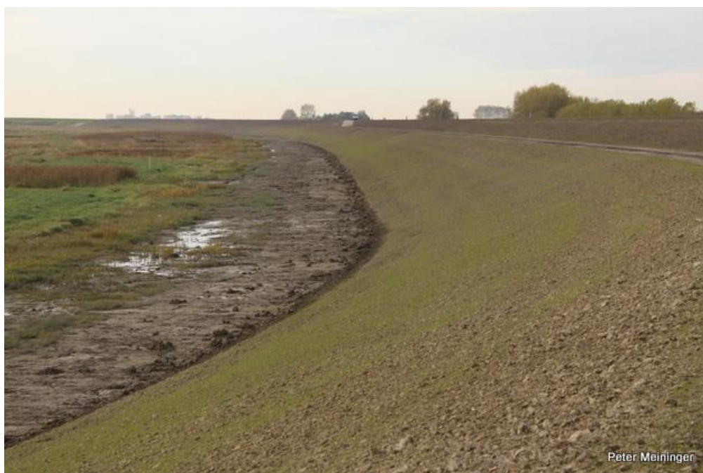
Dijktraject Schor Emanuelpolder. Afgewerkte werkstrook.
