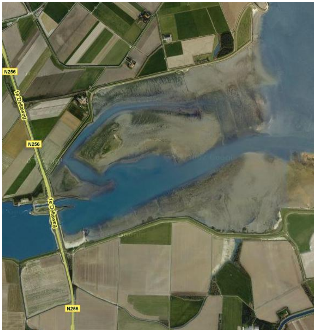
Figuur 2: Luchtfoto van het traject Wilhelminapolder, Zandkreekdam, Jonkvrouw Annapolder, Katspolder (bron: www.maps.google.nl )
